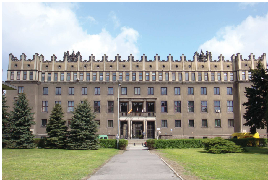
Ilustracja 4. Budynek „S” Centrum Administracyjnego kombinatu, fot. Jarosław Klaś, 2011
