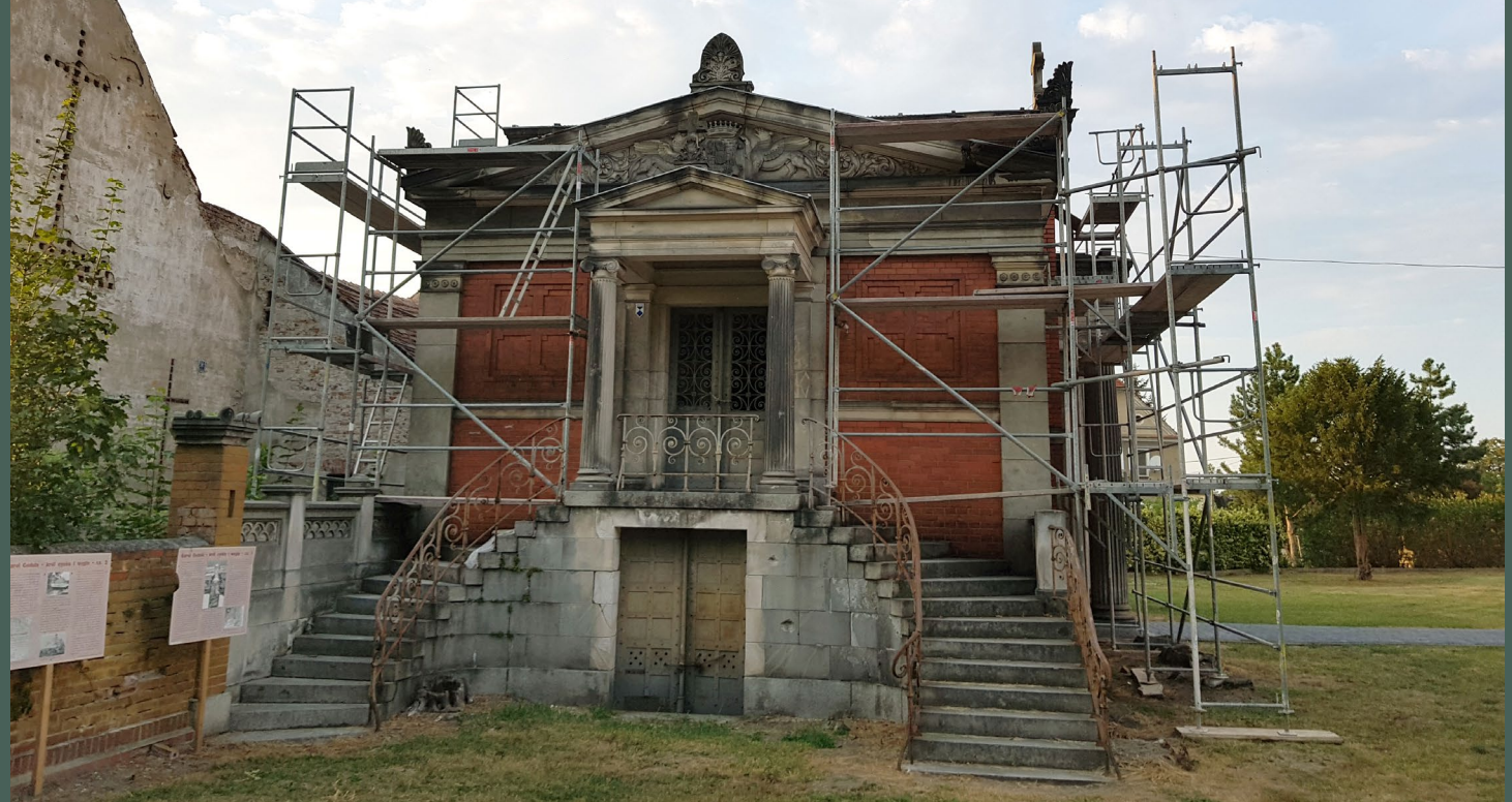
Mauzoleum w trakcie prac renowacyjnych w sierpniu 2018 roku (fot. M. Mischok)
